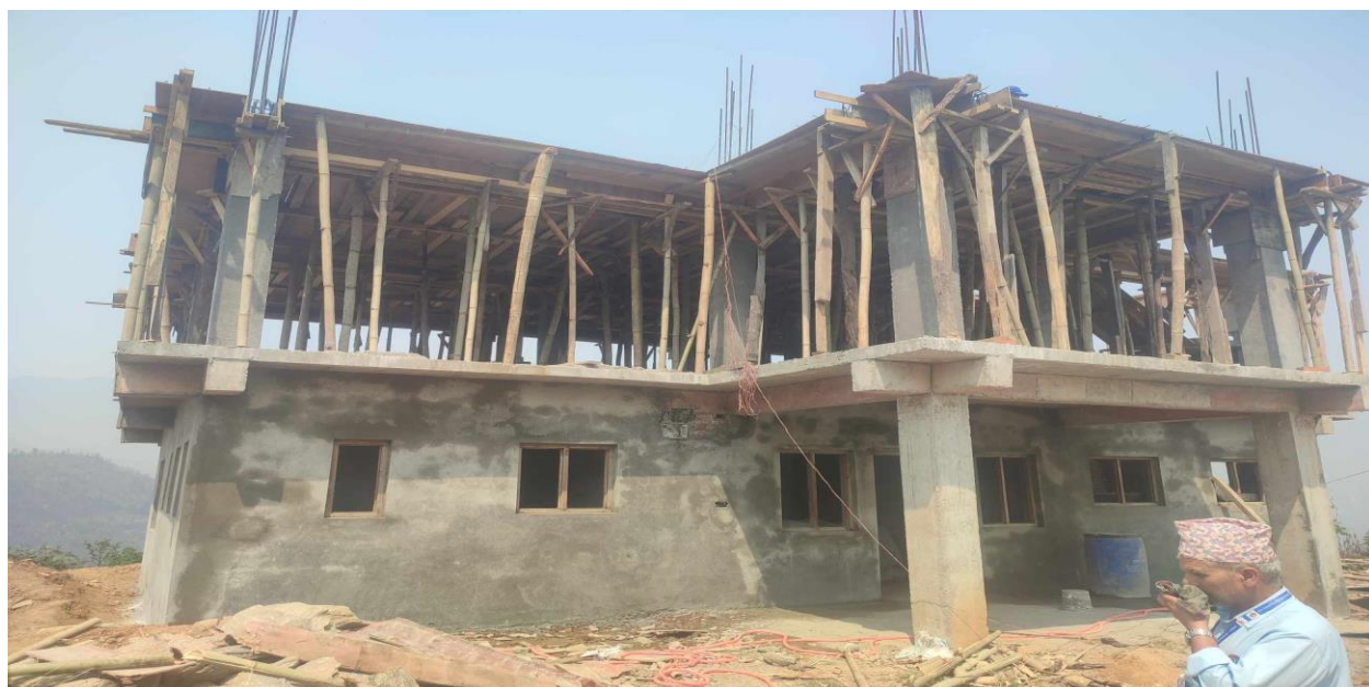
निर्माणाधीन २ नं. वडा कार्यालय, सैपु
